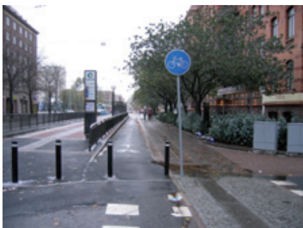
3:18 Eliminera onödiga konflikter. Olämplig placering av pollare.
