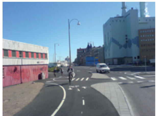
3:2 Otydlig linjeföring. Linjeföringen visar inte var huvudstråket går. Övergångsställe över cykelbana kan anses onödigt. Dessutom behöver plattorna nollas vid överfarten.
