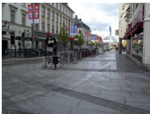
1:4 Otydlig ledning av cyklister
